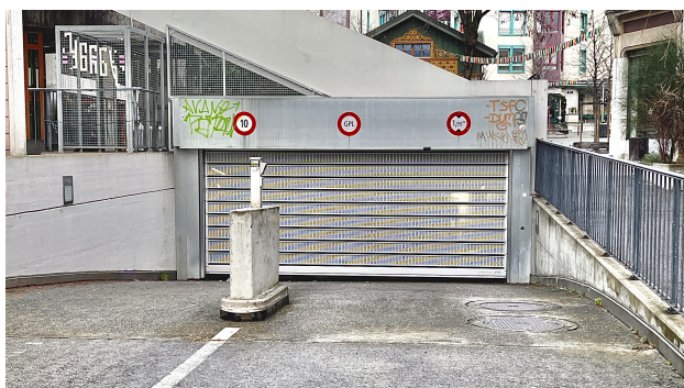
Image 4 - Entrée du parking souterrain
